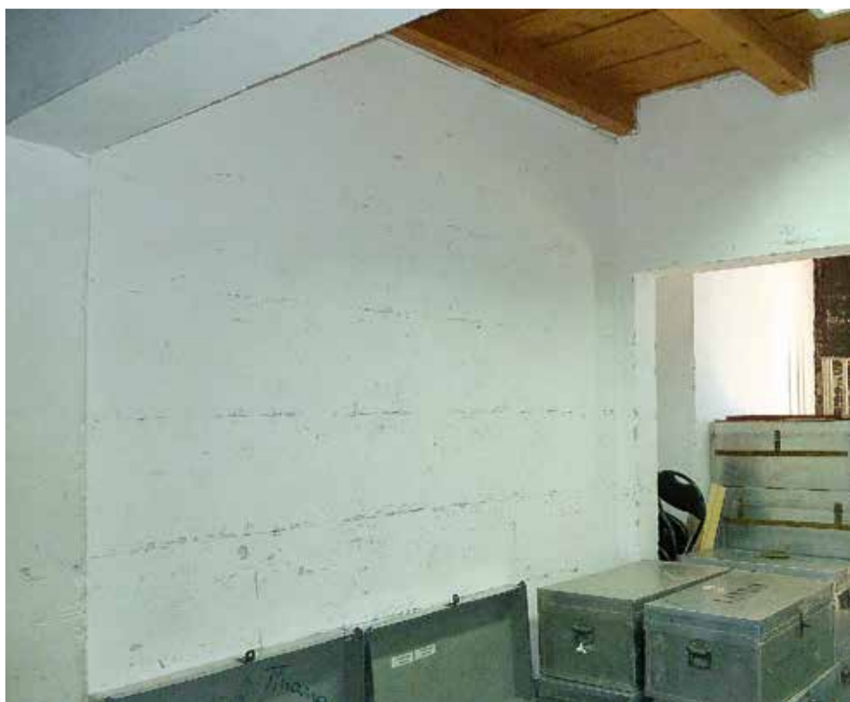
Zid iz kojeg su skriveni Meštrovićev reljef i gipsana skica
